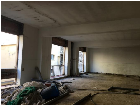
Figura 5 - Foto stato di fatto 2° Piano
