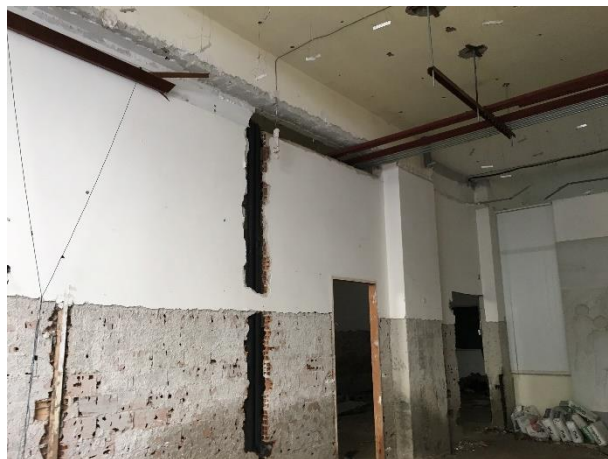
Figura 10 - Foto stato di fatto Piano Terra
