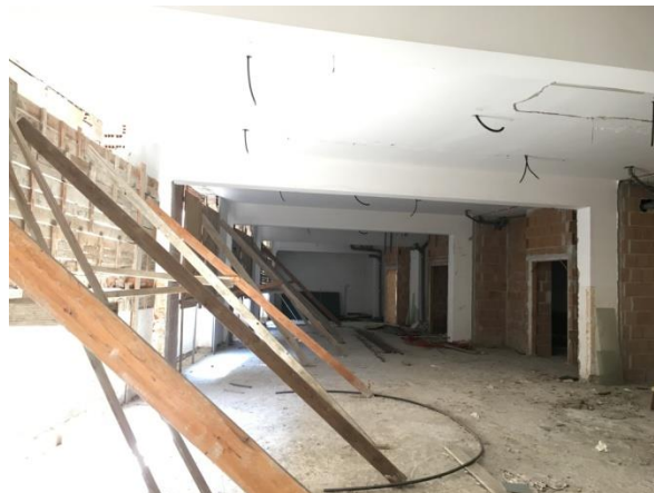
Figura 6 - Foto stato di fatto 2° Piano
