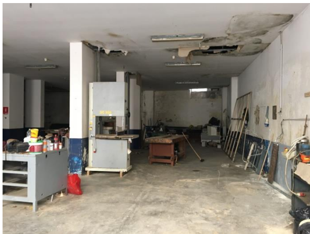
Figura 9 - Foto stato di fatto Piano Terra
