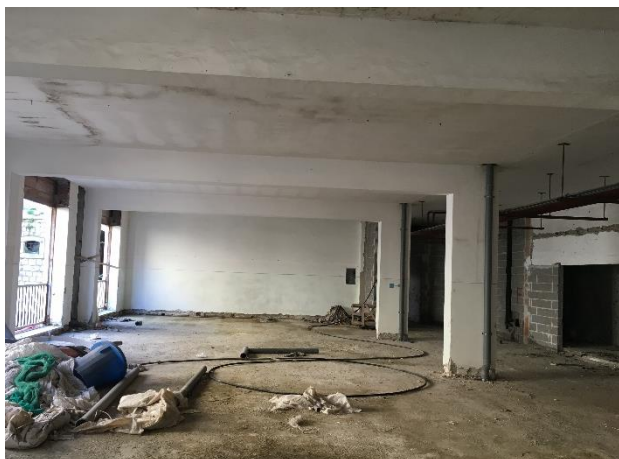
Figura 7 - Foto stato di fatto 1° Piano
