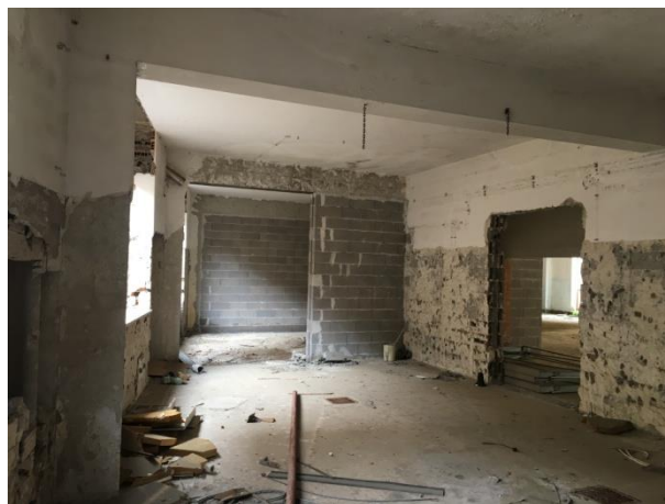
Figura 8 - Foto stato di fatto 1° Piano
